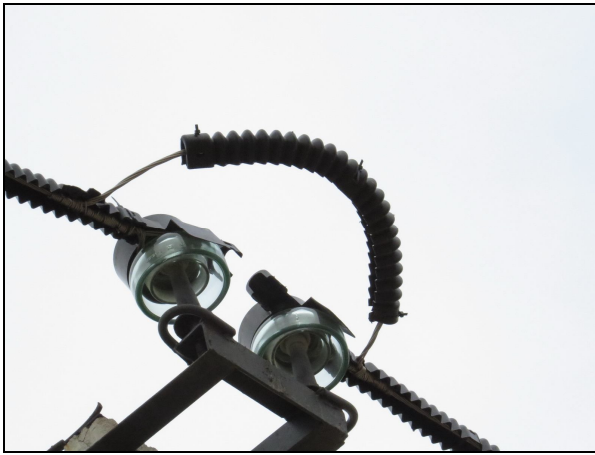
Рис. 8. Неполная изоляция участков проводов на ЛЭП компании "Мегафон".
