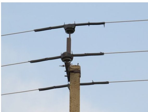
Рис. 7. Укомплектованные ПЗУ на ЛЭП с. Старый Чиндант - с. Новая Заря.
